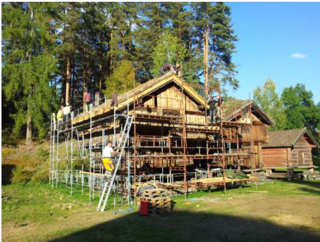
Frå restaureringa av Tveitloftet, Kviteseid Bygdetun september 2014
